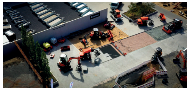
Chantier modèle à Coreum, Stockstadt a. R.
