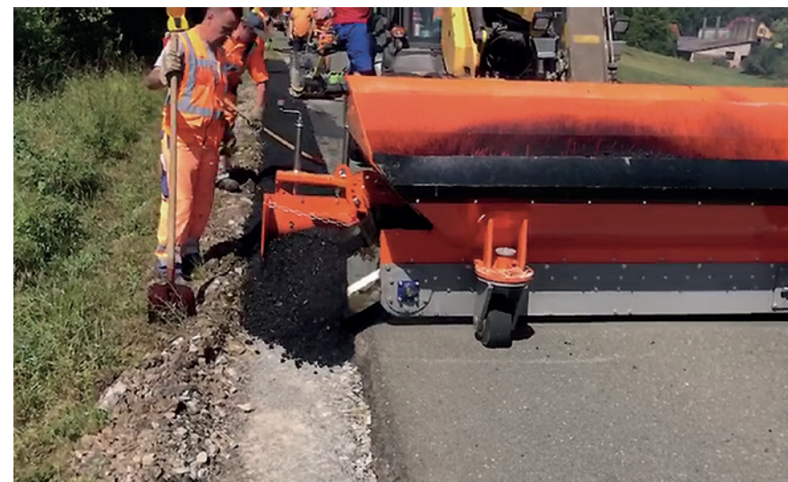
1,4 m³ Finliner Asphalteinbau
