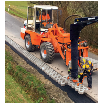
Verlegung Rasengitter-Steine mit Optimas-Vacu-Lift
