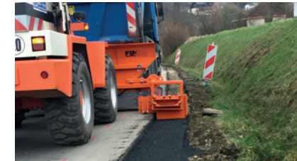
Materialverteilung: Abziehen mit Stahlschild
