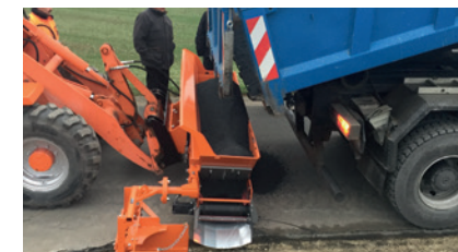
Die Schaufel wird direkt vom LKW befüllt.
