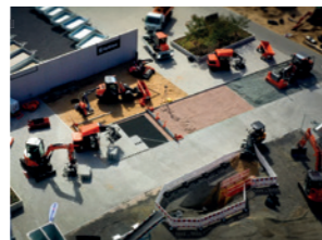
Musterbaustelle im Coreum, Stockstadt a. R.
