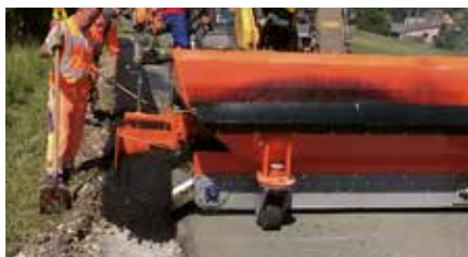
Asphaltbau (Schaufel 1,0 m 3 mit hitzebeständigem Förderband und Abziehschild, Gummi)
