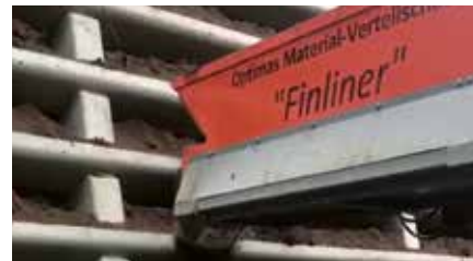
Befüllen Lärmschutzwand (Schaufel 1,0 m³ mit Materialrutsche, kurz)
