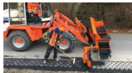
Rasengitter-Steine füllen mit Gummischild (Schaufel 1,0 m³ mit Materialrutsche, kurz und Abziehschild Gummi)
