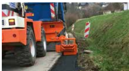
Materialverteilung: Abziehen mit Abziehschild Stahl (Schaufel 1,0 m³)
