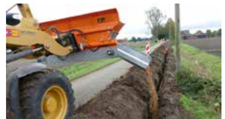
Absanden von Gräben und Leitungen (Schaufel 1,0 m 3 mit Materialrutsche lang)
