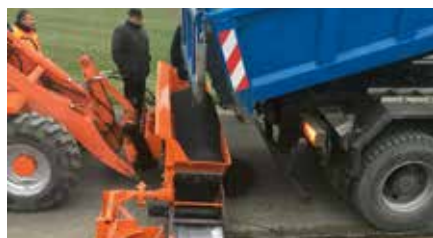
Die Schaufel wird direkt vom LKW befüllt
