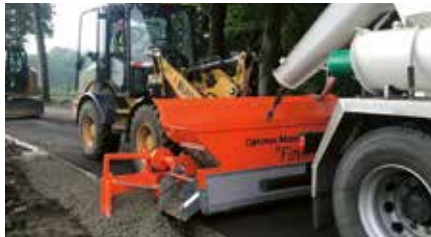
Bau von Randeinfassungen (Schaufel 1,0 m 3 mit Materialrutsche, kurz und Abziehschild Stahl)
