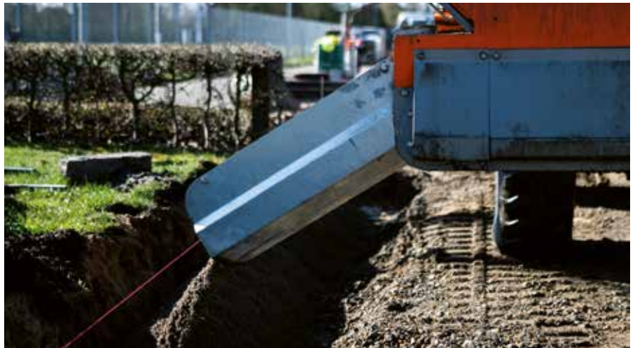
Bau von Randeinfassungen (Schaufel 1,0 m 3 mit Materialrutsche, lang)
