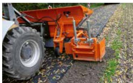
Verteilung von Schotter/Splitt im Bankettbau (Schaufel 1,4 m³ mit Abziehschild Stahl)
