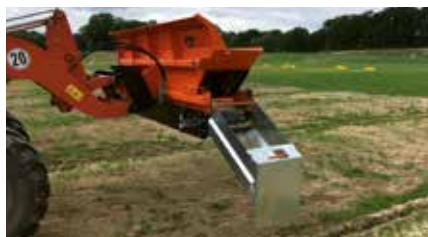
Drainagegräben mit Kiesel befüllen (Schaufel 1,0 m 3 )
