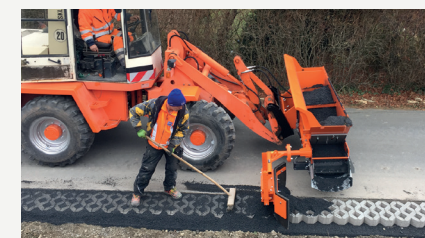
Rasengitter-Steine füllen mit Gummischild
