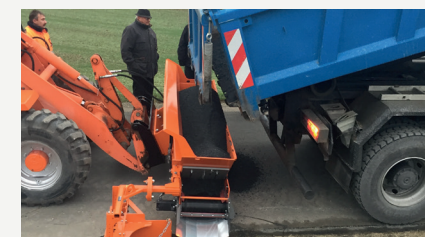
Die Schaufel wird direkt vom LKW befüllt.
